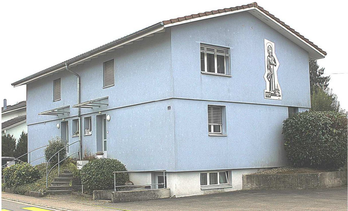
Verenahaus, Baujahr 1957, Arigstrasse 4, 6018 Buttisholz
